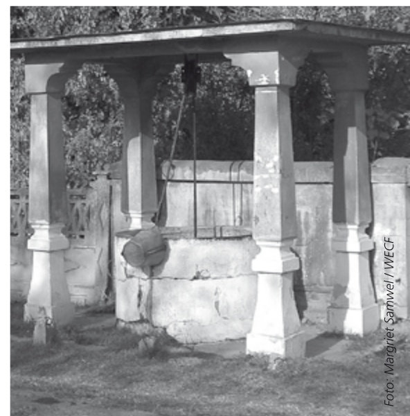
Trinkwasserbrunnen im ländlichen Raum in Rumänien
